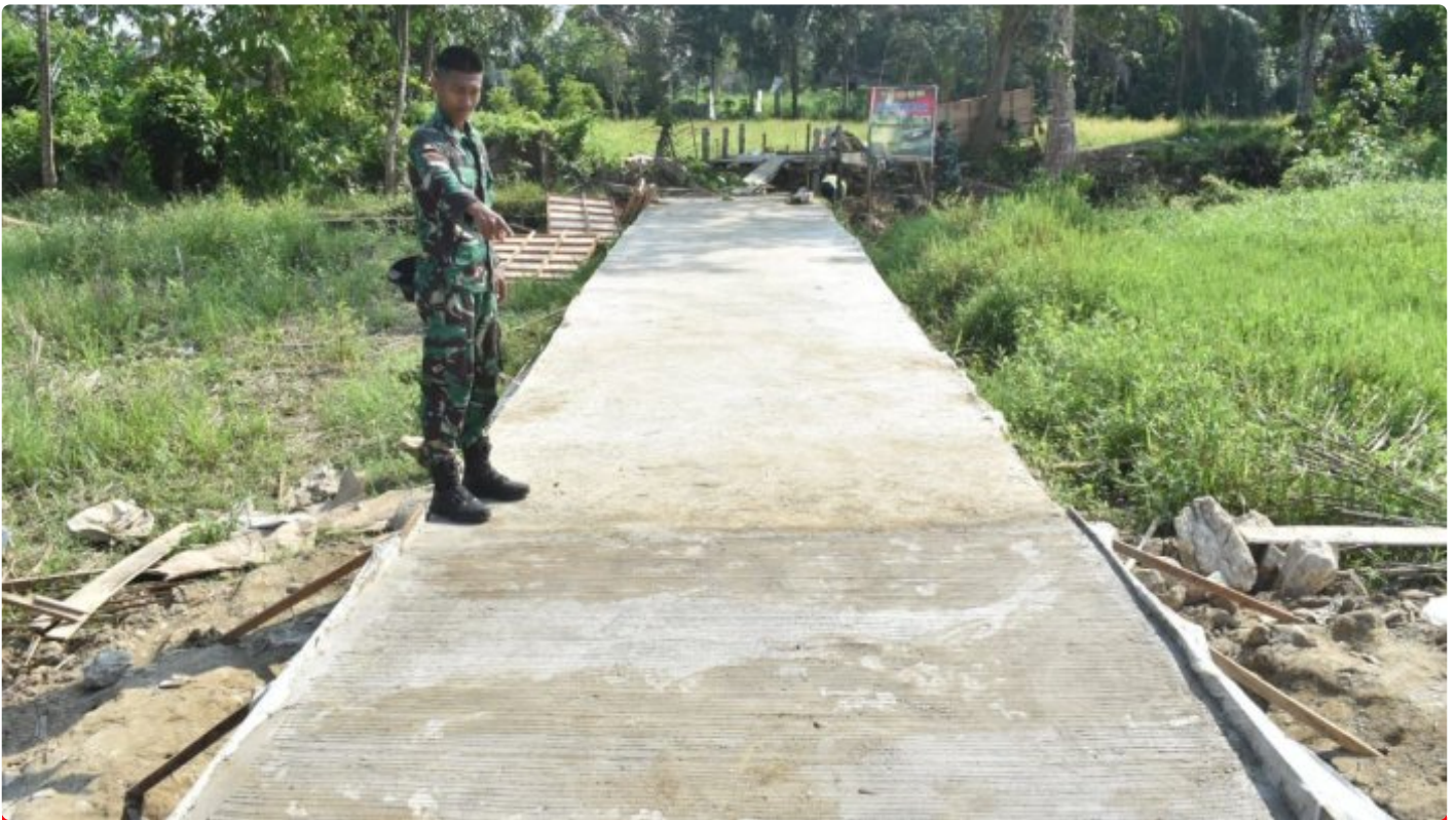
Gorong-gorong dan Slop Beton Rampung Seratus Persen
